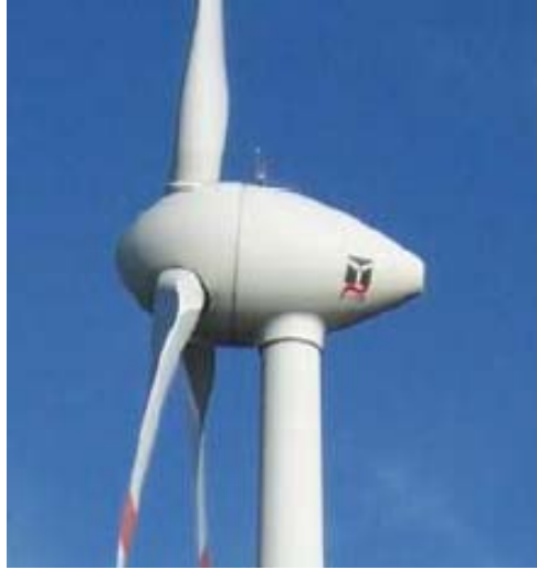
Fig. 3-2: Enercon E-112, 4.5MW
